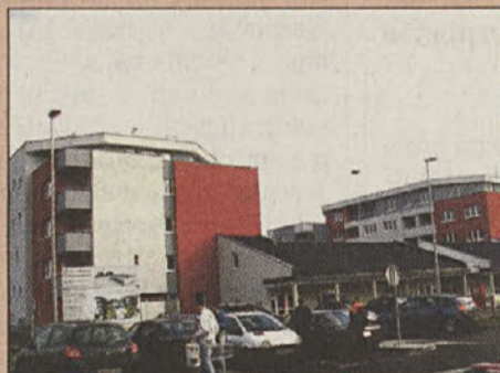
Zapolnjen stanovanjsko-poslovni objekt
