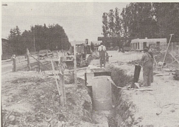
Gradnja Petrolovega bencinskega servisa v Krškem
