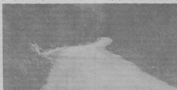
Del ceste Zagradec — Ambrus, ki je bil asfaltiran v lanskem letu
