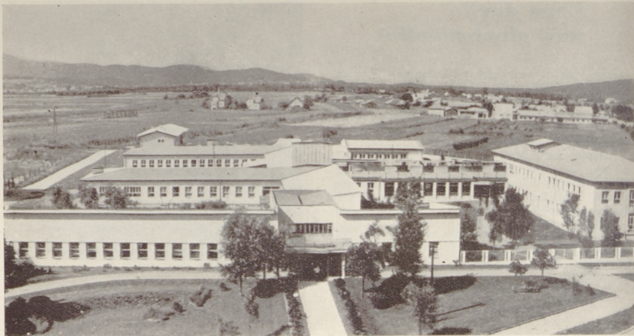
Zavod za rehabilitacijo invalidov v Ljubljani
