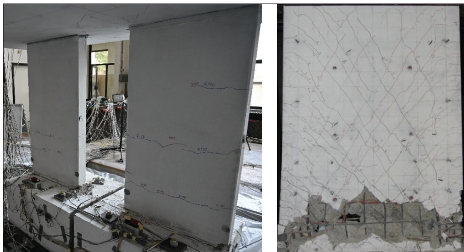
Slika 8 • Razpoke v stenah testirane konstrukcije (levo), razpoke, ki so značilne za konzolne stene (desno).
