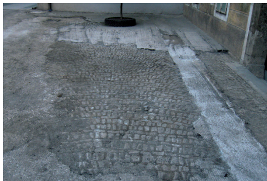
Dokaz o načinu polaganja granitnih kock na Spodnjem trgu. (foto: Ines Košenina)
