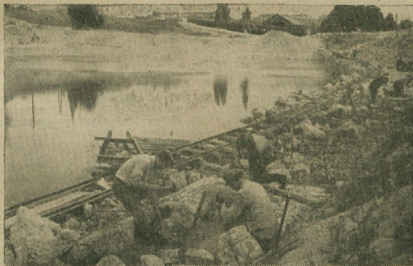
Kameniti zid pri regulaciji Savinje
