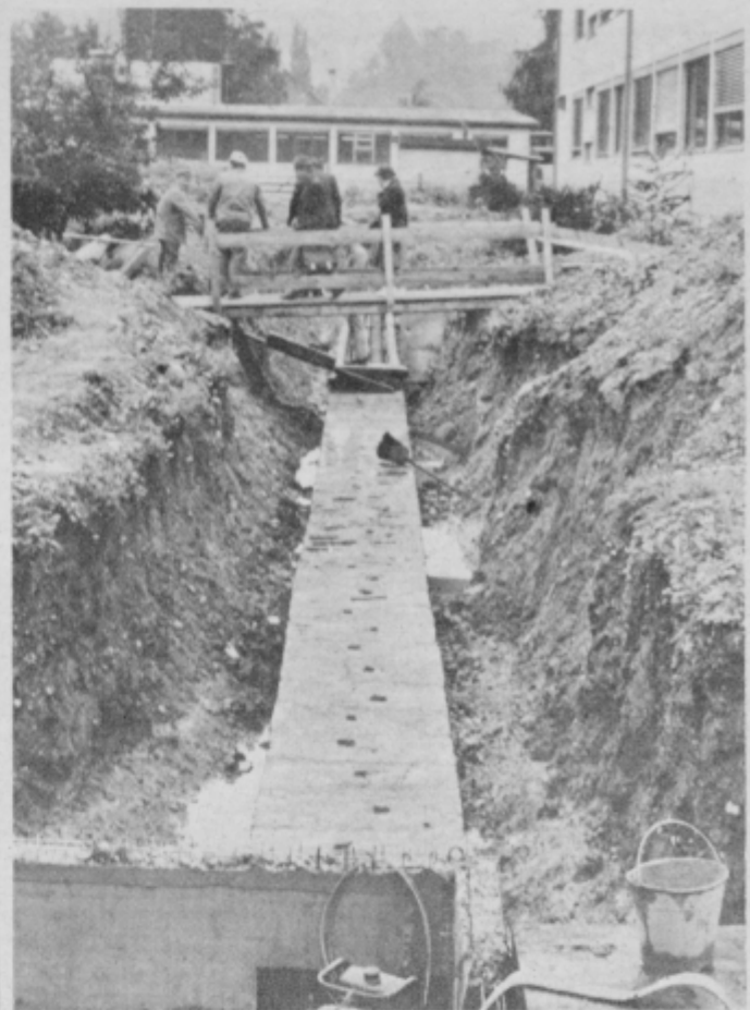
Gradbena dela bodo končali v roku.
