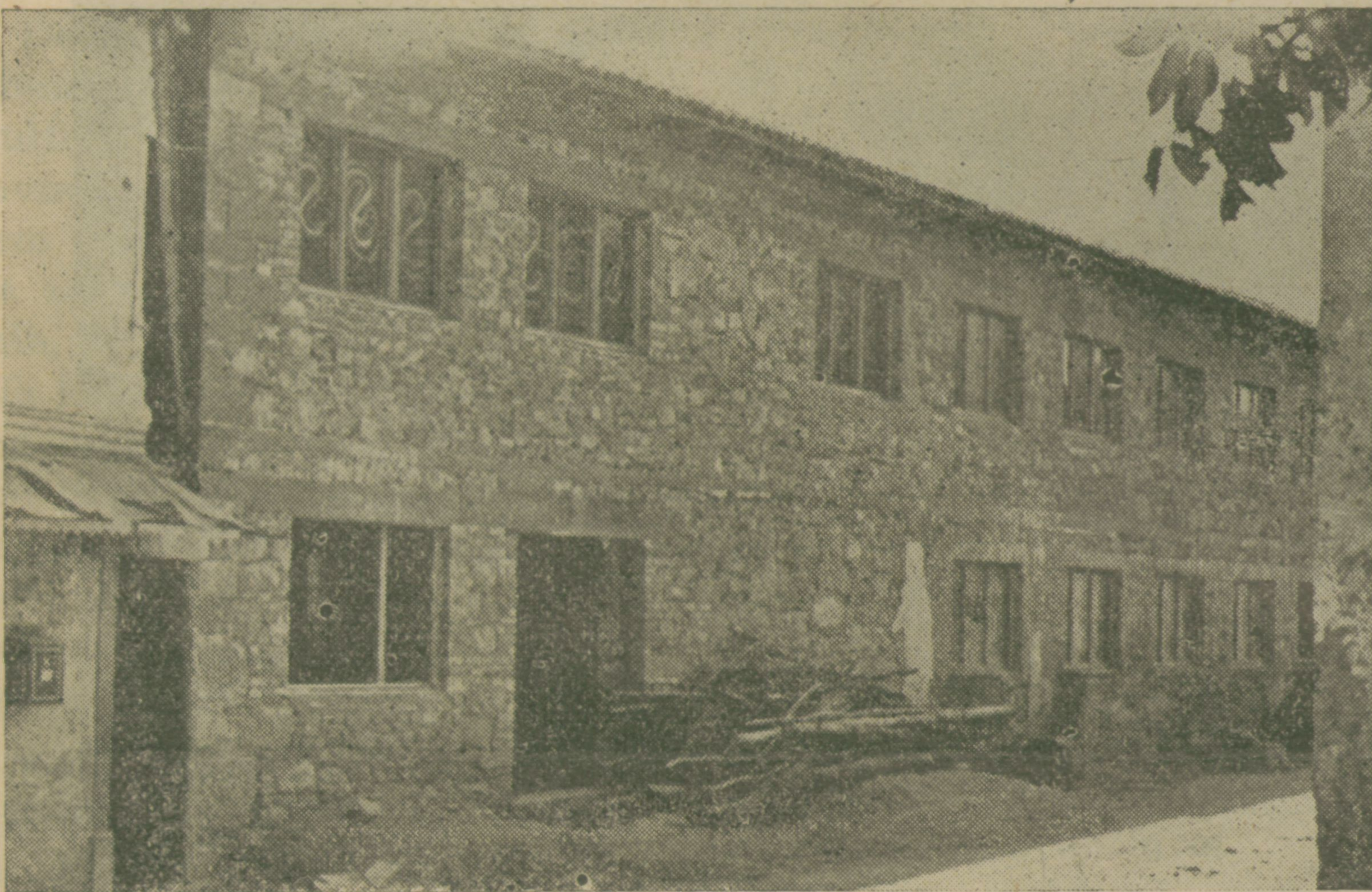
Kulturni dom na Baču je že pod streho
