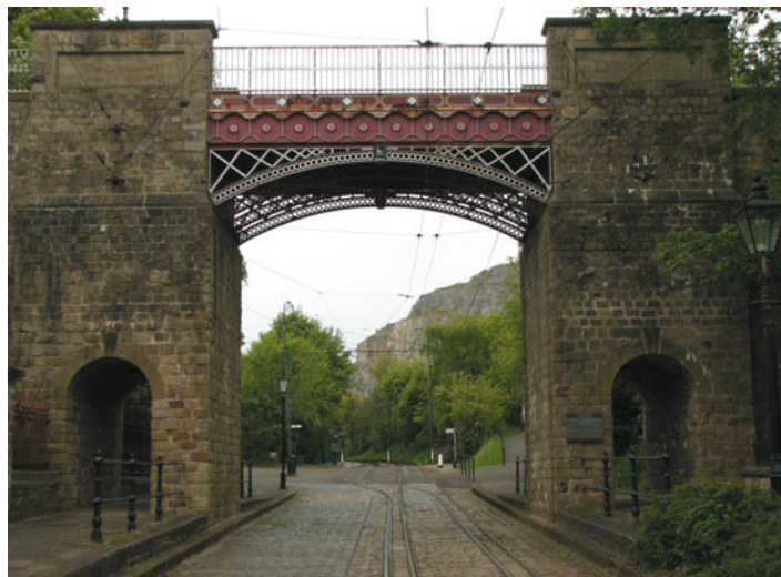
Železna konstrukcija mosta
