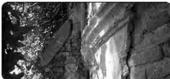
Strešice stopnjevanih opornikov z odkapnimi profili ter podnožja opornikov so kamniti.
