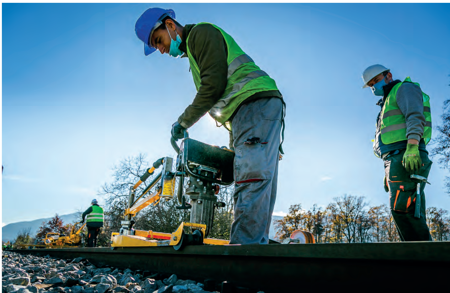
Intenzivna prenovitvena dela na gorenjski progi se nadaljujejo tudi januarja.
