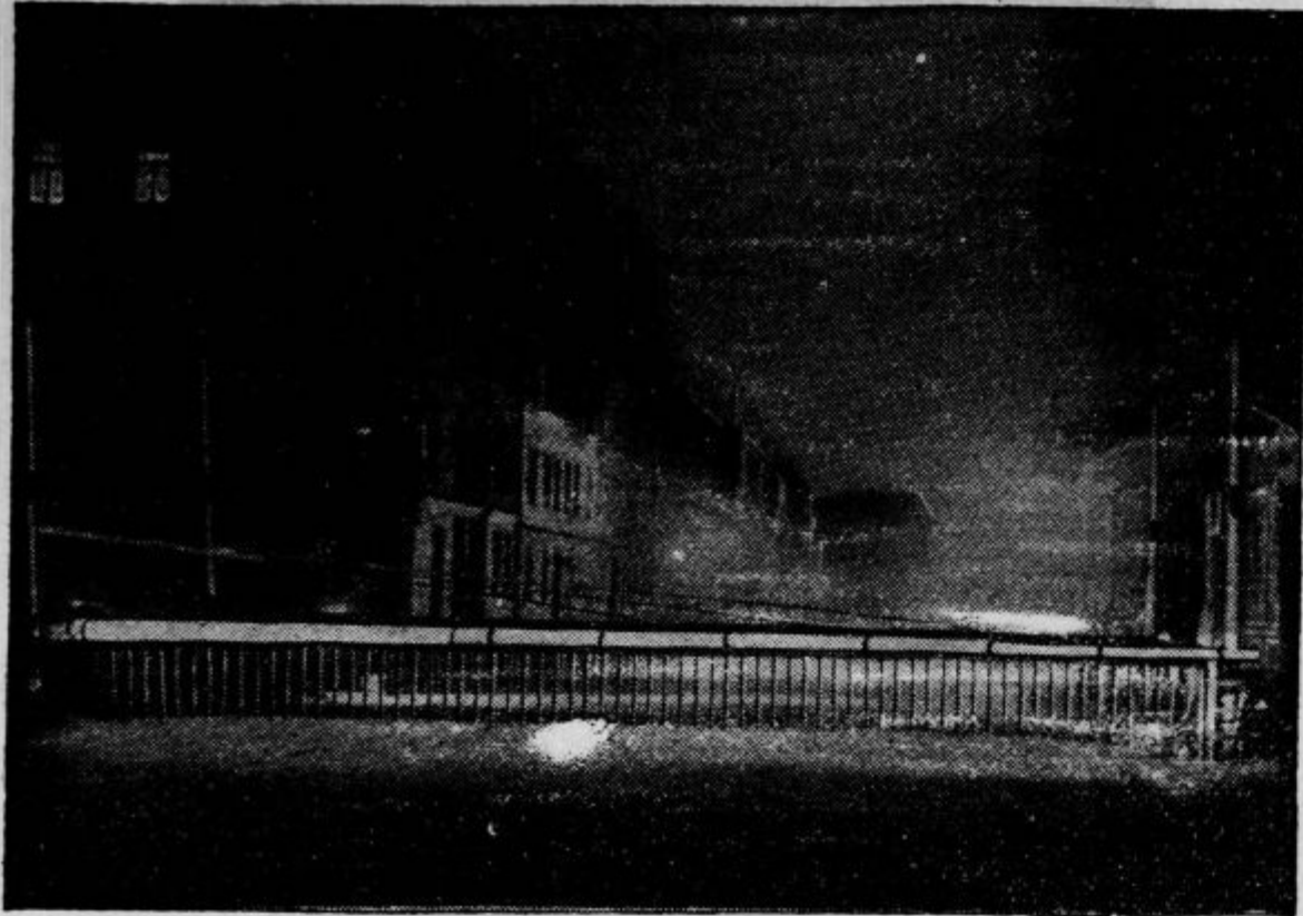
Neki inženjer je skonstruiral avtomatično zapornico, ki se pri spuščanju čez cesto sama zasveti in ostane v tem stanju dokler ne zdrdri mimo vlak
