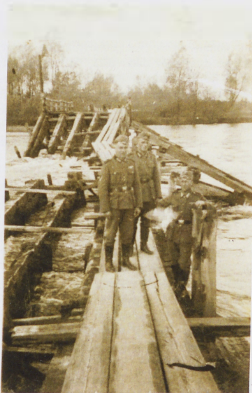
Nemški vojaki na porušenem mostu v Veržeju, 1941
