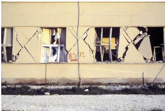
Slika 2 • Strižna porušitev opečnih slopov med potresom
