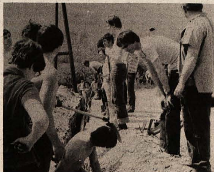
TELEFONSKI KABEL ZA KOSTELSKO - Člani kolektiva PTT Ljubljana so na solidarnostni akciji na Kostelskem položili kabel za zvezo s Kočevjem in lokalni kabel za 200 možnih telefonskih naročnikov. (Foto: Primc)
