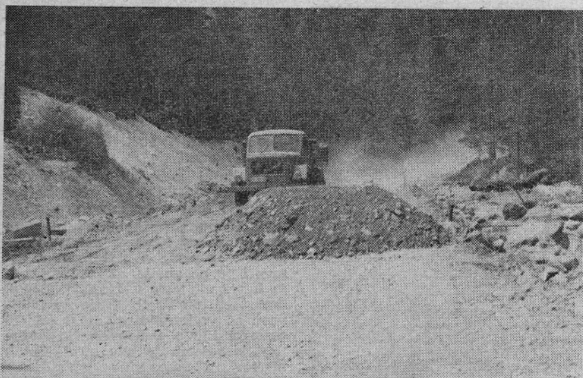
Na cesto od Igle proti Solčavi bodo kmalu začeli polagati asfalt
