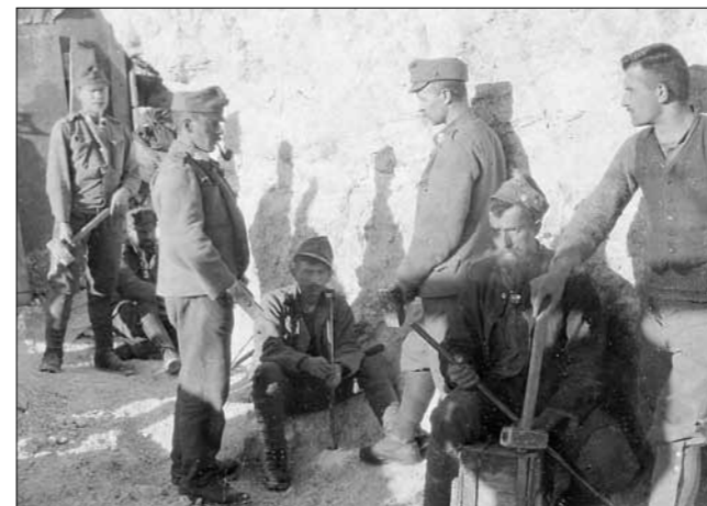
Klesali so z velikimi dletji, po katerih so tolkli z macolami. Za vklesavanje kavern (vsaj za nekatere) pa so uporabili vrtalni stroj. Foto: Ivan Milač, julij 1916.
