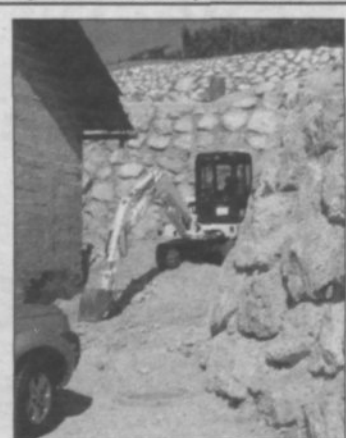
Nedavno saniran plaz pri Glasovih na Koritnem
