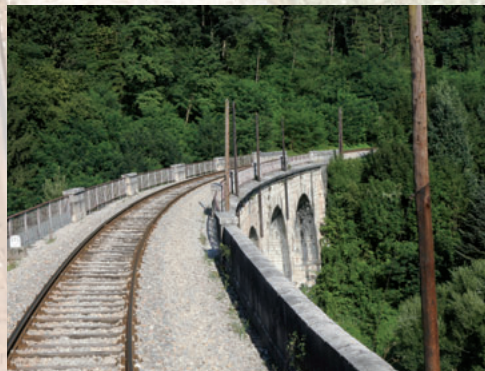
Viadukt pri Prevaljah
