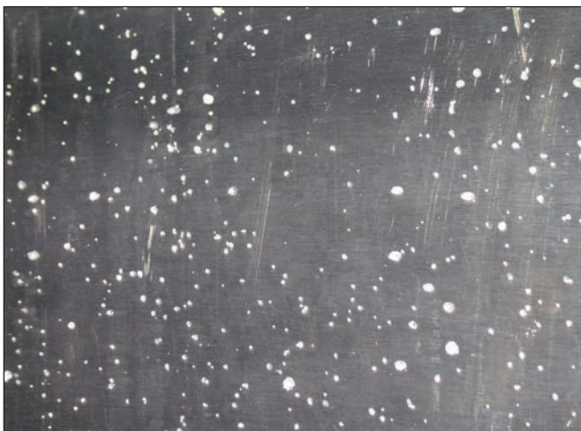
Slika 2. Jamičasta ali pitting korozija na plašču cisterne
