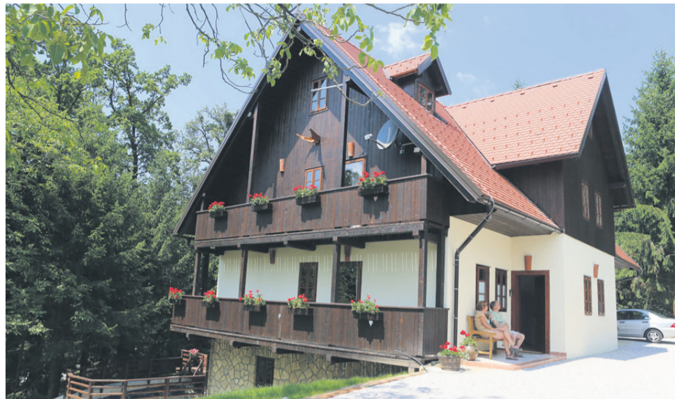
Čprav ima hiša star kmečki videz, v njej ne boste videli nobenega hladilnega ali grelnega medija. Ogrevanje je speljano preko talnega gretja. Ko se živo srebro na termometru poleti povzpne, v spodnji del betonske plošče toplotna črpalka črpa hladno vodo in poskrbi za hlajenje. Prezračevanje je urejeno z rekuperacijo (to je način ogrevanja z vračanjem toplote) in zahteva minimalno porabo energije.
