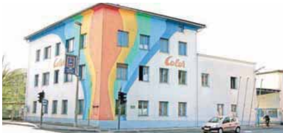
Na prostoru nekdanjega Colorja so predvideli gradnjo poslovno-trgovskega kompleksa.
