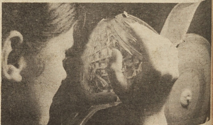
Za brušenje kristala sta predvsem potrebna mirna roka in smisel za oblikovanje. Steklenica, ki je prišla grobo narejena v roke temu dekletu, počasi dobiva oblike dragocene kristalne steklenice
