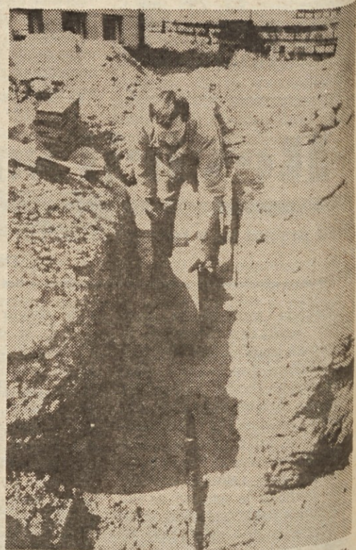
Nov proizvod – lesene deščice za zaščito zemeljskih kablov – so pravzaprav najprej preizkusili kar doma. Električni kabel za novi obrat so zavarovali prav z njimi
