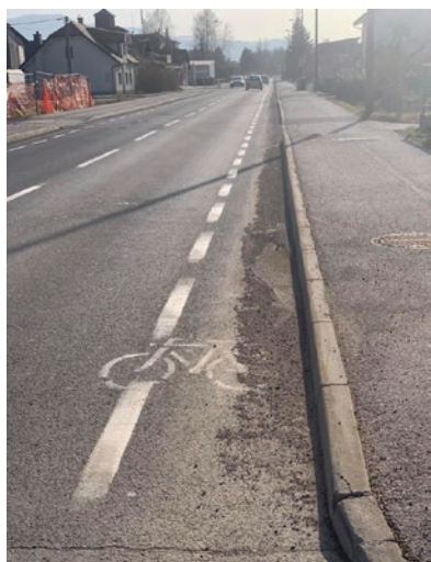
Slika 16: Pesek na preozkem kolesarskem pasu na Jurčkovi cesti (foto: Lea Rikato Ružič).
