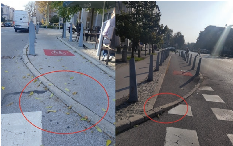
Slika 13: Neudobno in nevarno izvedeni detajli (količki, robniki) na kolesarski stezi (foto: Lea Rikato Ružič).
