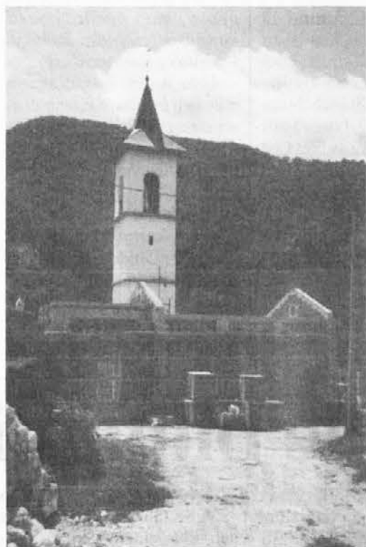
Procedono a ritmo sostenuto i lavori di ricostruzione della chiesetta di Coritis
