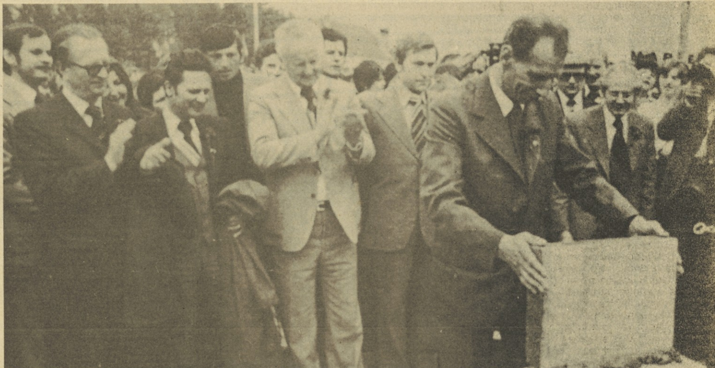
Postavitev temeljnega kamna za novo tovarno v Makolah 23. aprila 1977, rojstnem kraju dr. Štefana Šobe
