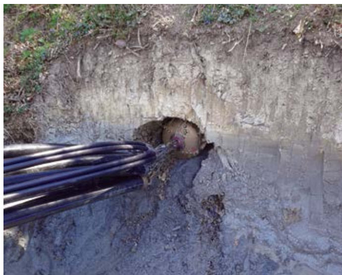
Vlečenje kablov skozi vrtino.
