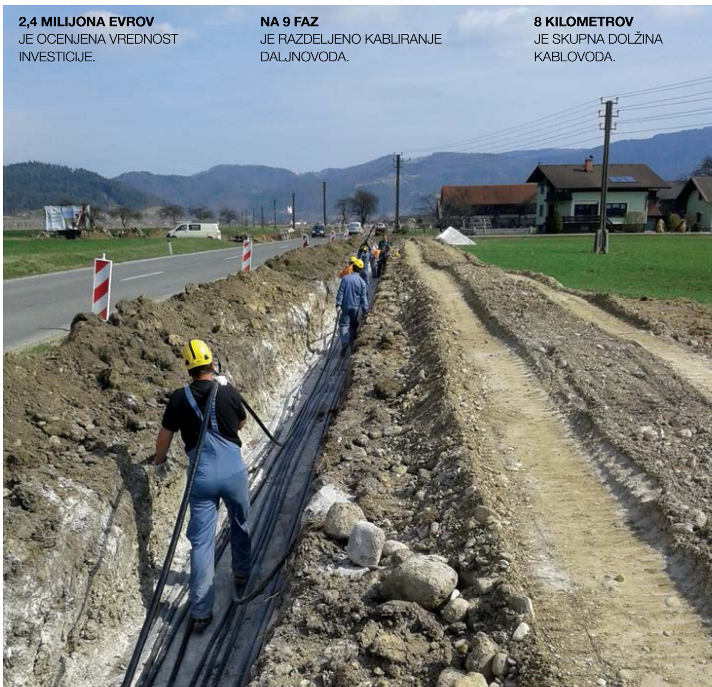
Vlečenje kablov v bližini Varpolja (marec 2017).
