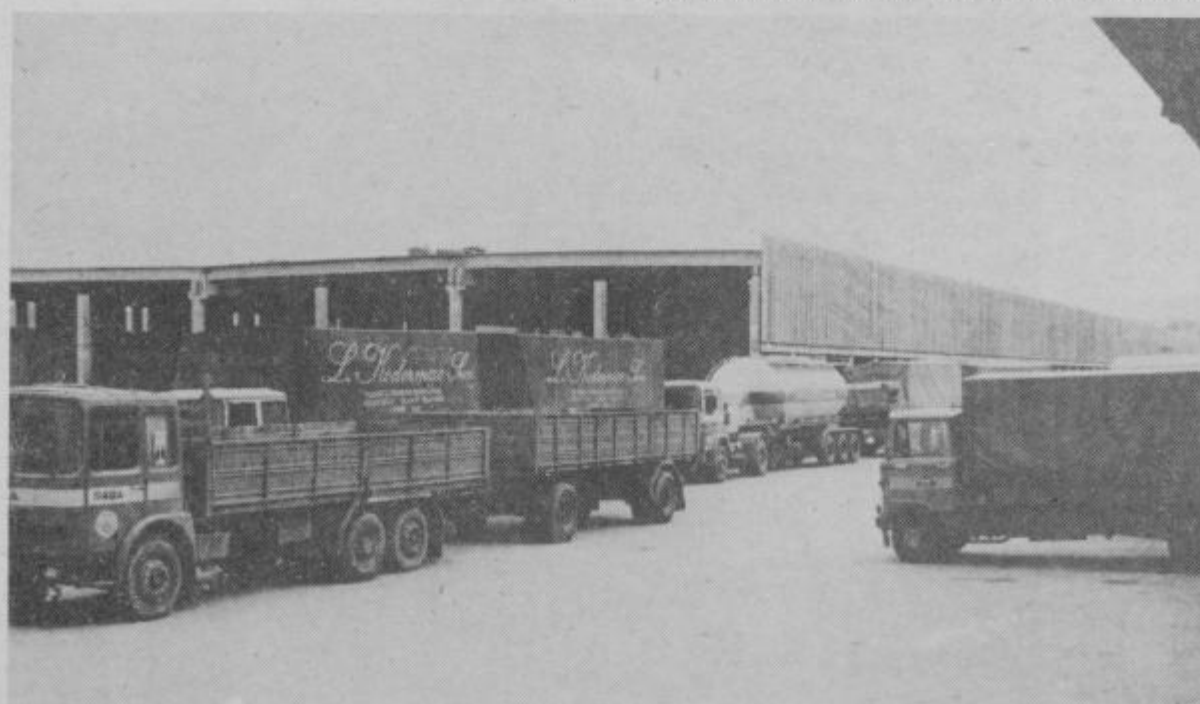
Na prostoru Javnih skladišč v Čretu v Celju vselej velika gneča, zadaj nova hala B, ki je zrasla v rekordnem času
