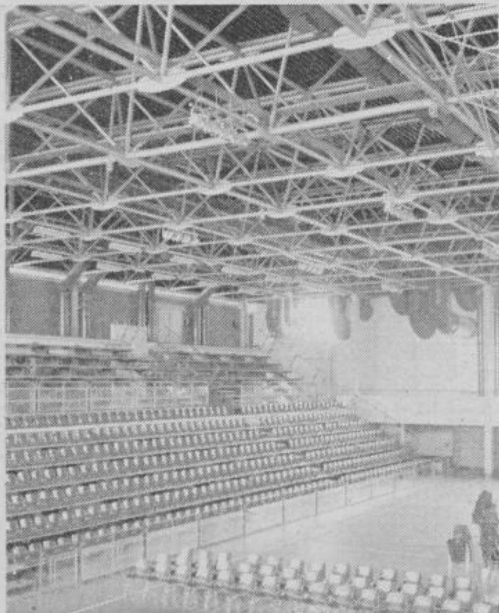
Sportna dvorana Golovec v Celju - Klime je izdelala kompletan sistem klimatizacije in ventilacije.
