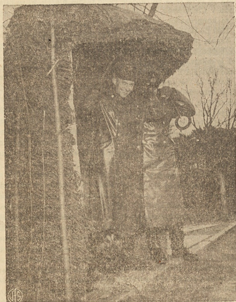
"PODRUŽNICA" — Zahodnoberlinski cariniki na meji sovjetske cone Nemčije so si zgradili tale "podružnični" urad iz dračja, ki jih kar dobro varuje pred dežjem.
