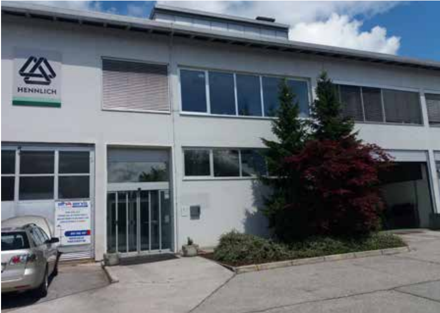
Poslovna stavba podjetja Hennlich v Kranju
