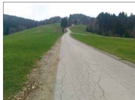
Obnova vodovoda Prhajevo–Pušče
