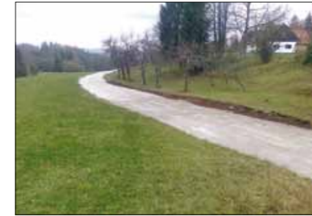
Izvedena zemeljska dela na odseku Lužarji–Naredi
