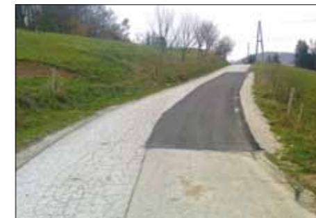
Sanacija poškodovanega asfalta v naselju Kot
