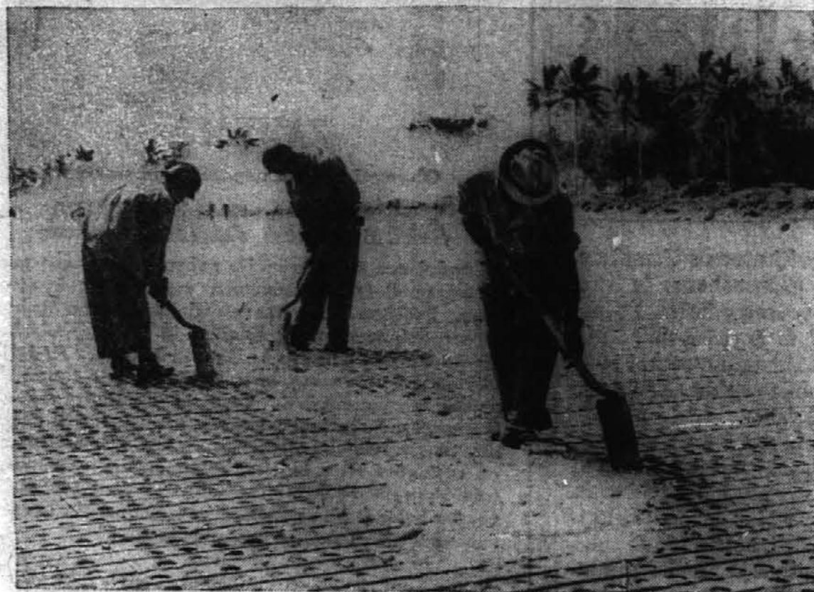
Nekje v Južnem Pacifiku kaže slika, kako grade ameriški inženirji prostor za letalsko postajo. Vzelo je 18 dni, da so očistili prostor in istega izravnali. Površino najprej pokrijejo s kamenjem in nato s kovinastimi ploščami, da so tla solidna.
