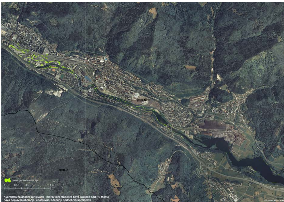
Slika 5.7: Ortofotoposnetek novih poplavnih območij na odseku Save Dolinke nad HE Moste
