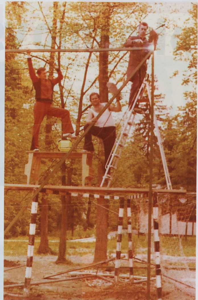
Ob gradnji šolskega igrišča. Na sliki z leve Viljem Škornik, Leopold Tanšek in Miha Lukanc.
