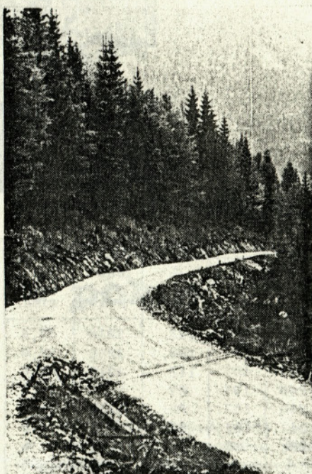
Način gradnje gozdnih cest v zadnjih letih - foto GG Bled
