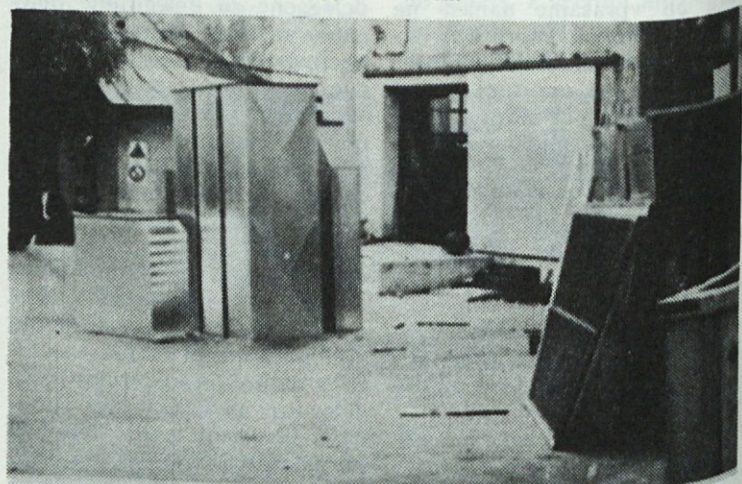
Delavci Industrijskega montažnega podjetja Ljubljana so v Predilnici I — bombaž, montirali zračni kanal pri klimatski napravi, ki bo nekoliko ublažil poletno vročino v oddelku. Kdaj pridejo na vrsto te naprave v drugih oddelkih?
