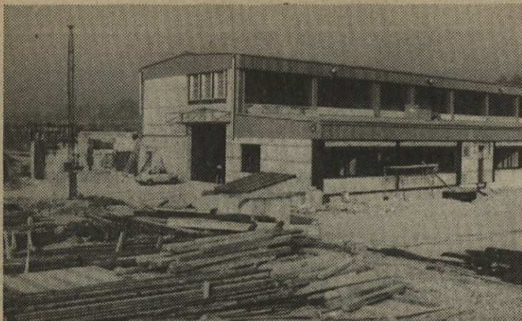
Vrhovo. Montažna hala strojnice je pokrita in zaprta...
