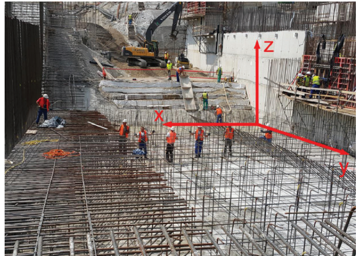
Slika 12. Postavitev koordinatnega sistema [Vežočnik, 2015].
