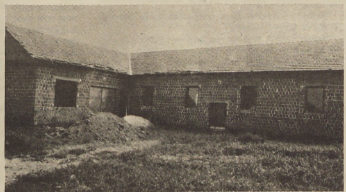
Vaško-gasilski dom je skoraj dokončan, saj je funkcionalno že uporaben, dokončno pa ga bodo dokončali prihodnje leto.
