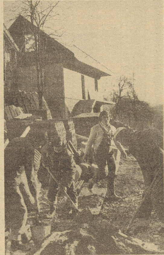
Ves material za vzdavo oken in vrat so brigadirji pripeljali s seboj. Malto so pripravljali kar ročno.
