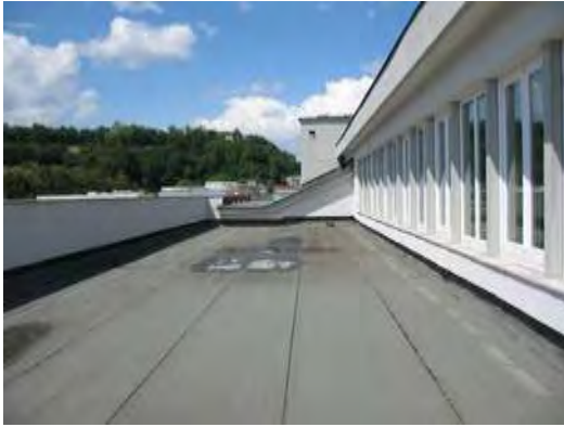
Sliki 5 in 6: Streha šole prej in potem
