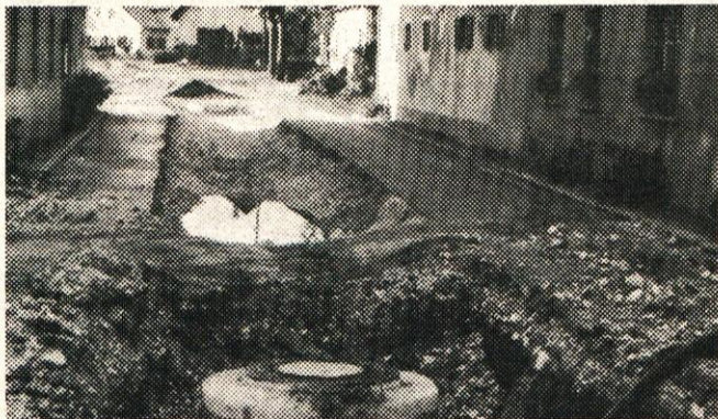
Takole gradijo kanalizacijo na Škrjančevem. Kako poteka ta gradnja, lahko vidite tudi v pisani besedi.
