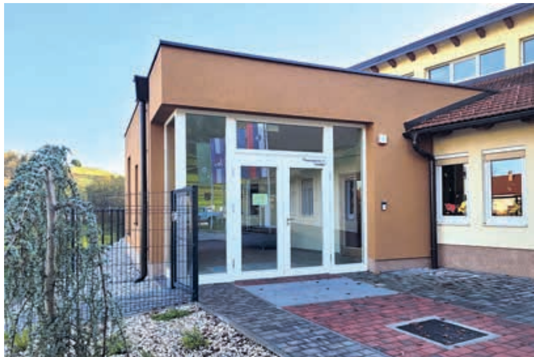
Vhod v prizidek, ki je energetsko izredno učinkovit, saj je zgrajen po najsoodobnejših standardih EKO gradnje.
