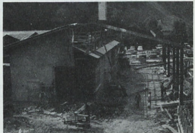
Začetek gradnje novih prostorov (foto: Galjot M.)
