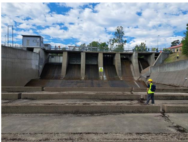
Slika: Prelivna polja hidroelektrarne v Dals Långedu (📷 P. Žvanut)
