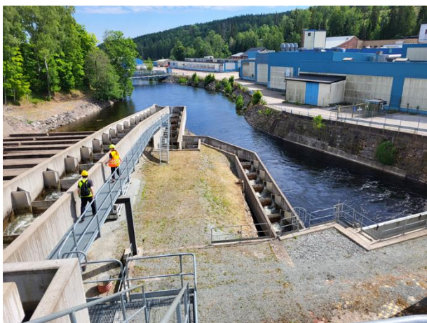
Slika: Ribja steza na hidroelektrarni v Dals Långedu (📷 N. Smolar Žvanut)
