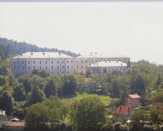
Pogled na kompleks starih vojašnic v Pivki pred začetkom obnove julija 2006.
