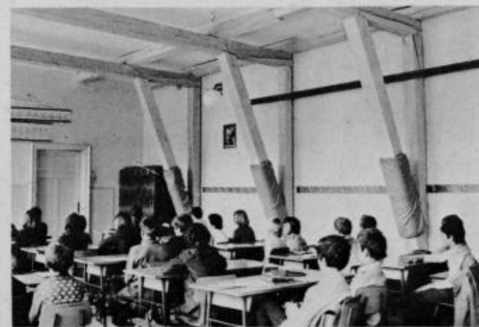
V enem od razredov osnovne šole Bratov Štrafela v Markovčih. Strop je krepko podprt, zato učenci niso v nevarnosti. Foto: R
