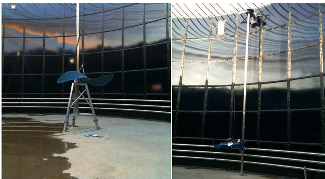
Slika 49: Potopni mešali v anaerobnem reaktorji BPE Vučja vas.
