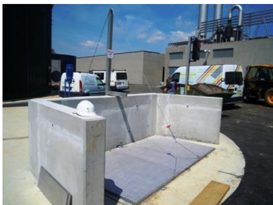
Slika 50: Mešalna jama (MJ) za doziranje substratov.
