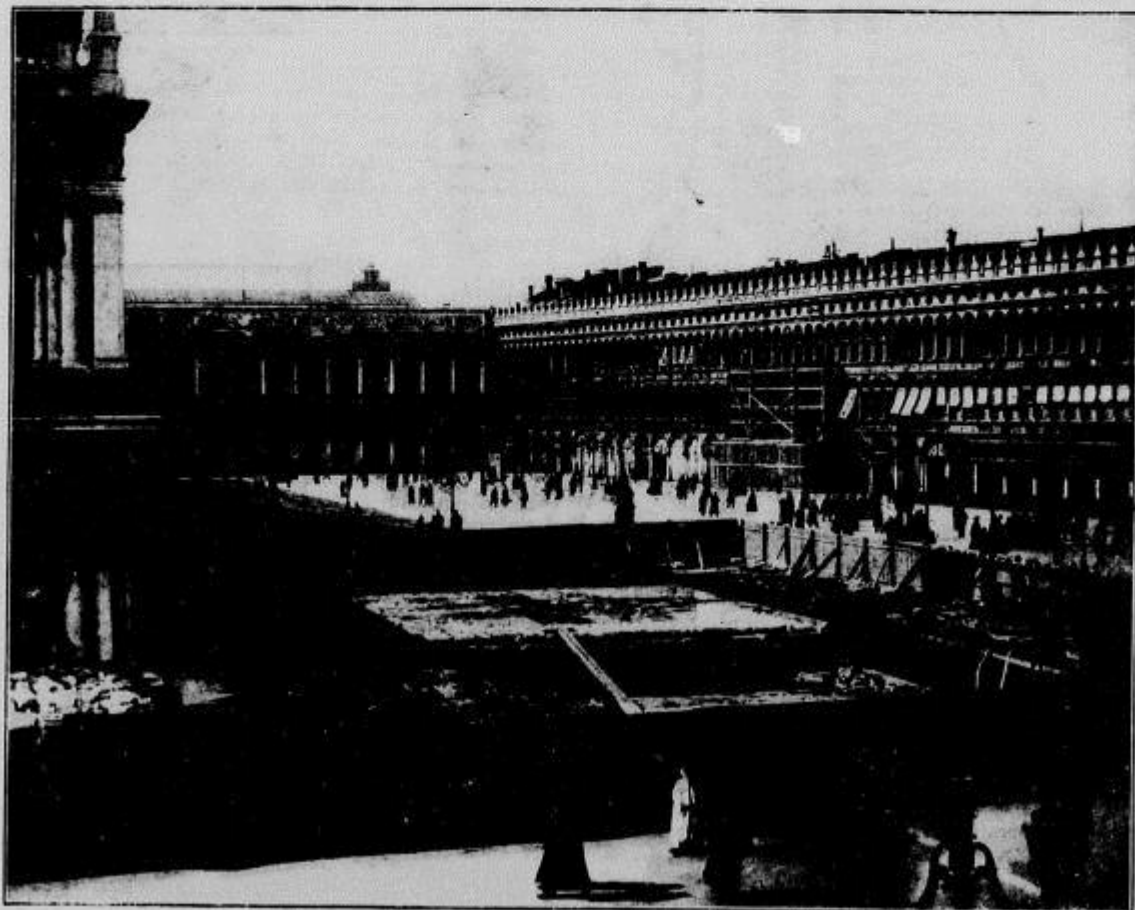
Zum Wiederaufbau des Campanile in Venedig: Der bloßgelegte Unterbau.
